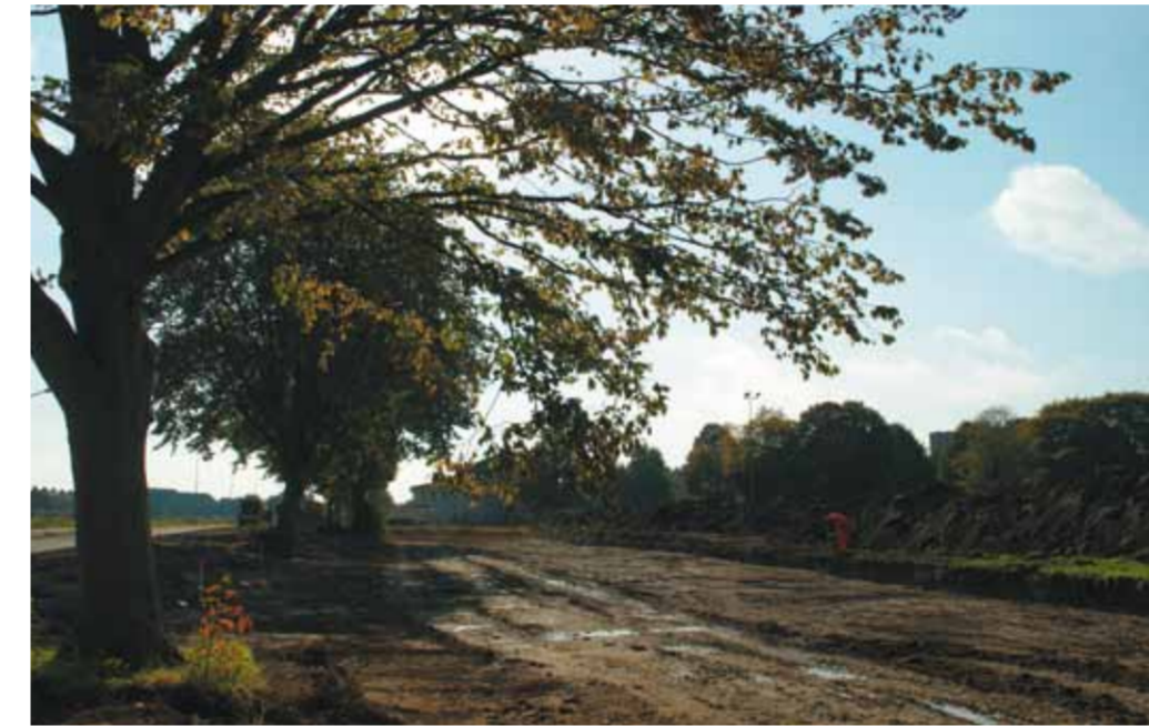
De werkzaamheden aan de parkeer- en wandelzone aan de Tamboerijnstraat zijn in volle gang
